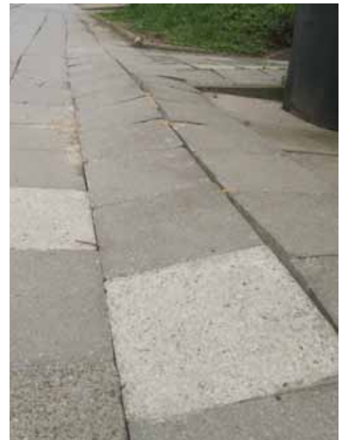
Chodník ul. Prlovská
