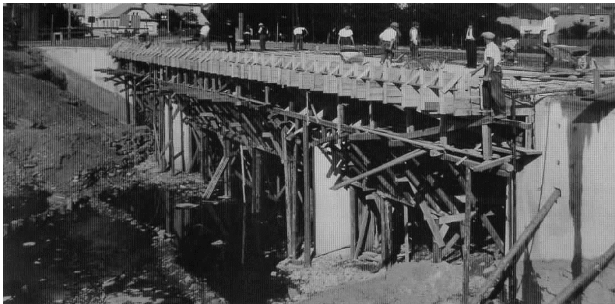
Obr. 8: Stavba mostu na Cigánově (Řehák)
